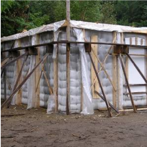
Fig. 15. Completed Concrete Pour
