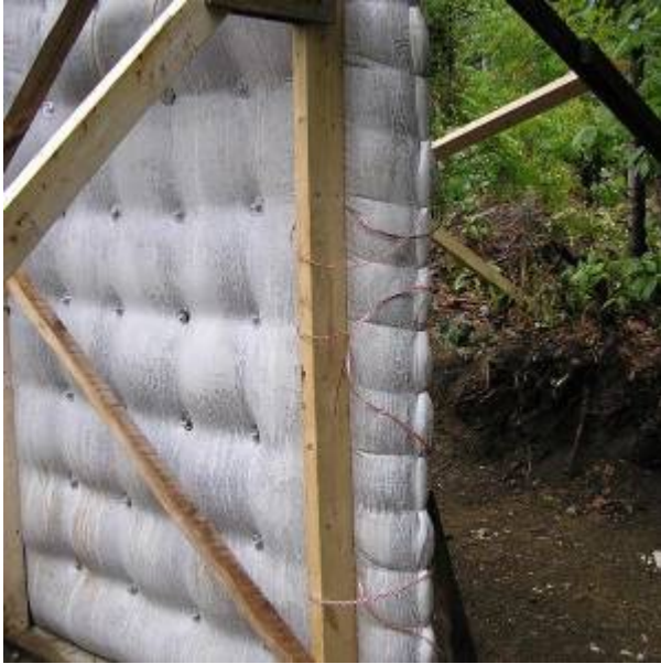
Fig. 16. Completed Concrete Pour
