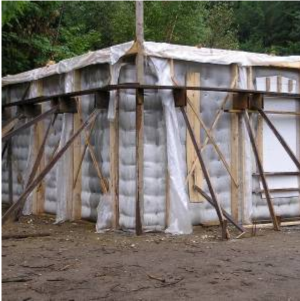
Fig. 15. Completed Concrete Pour
