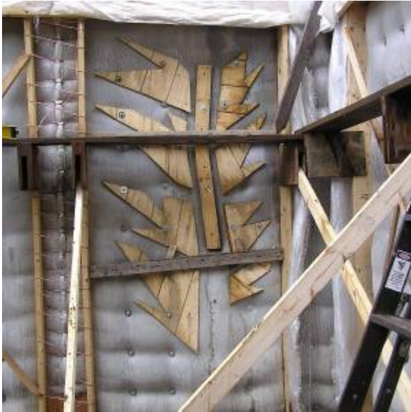
Fig. 18. Completed Concrete Pour
