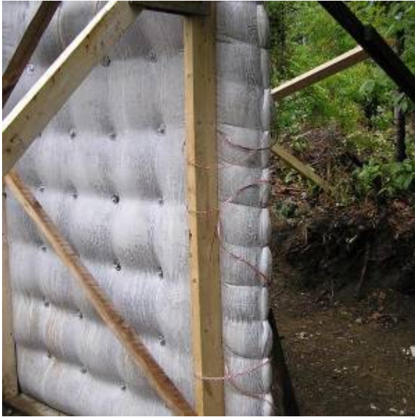
Fig. 16. Completed Concrete Pour
