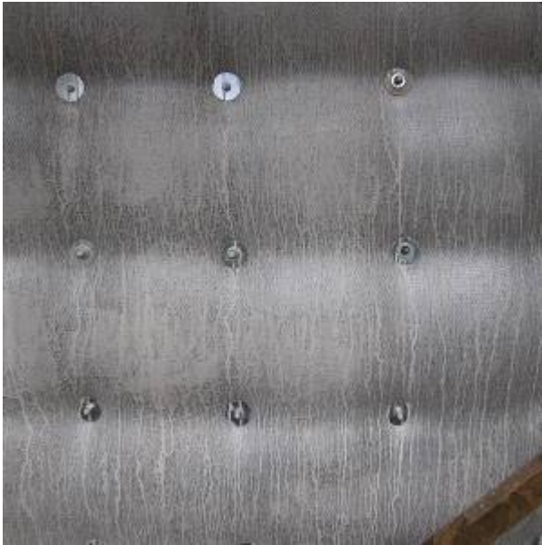
Fig. 17. Completed Concrete Pour
