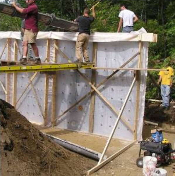
Fig. 10. Concrete Pour
