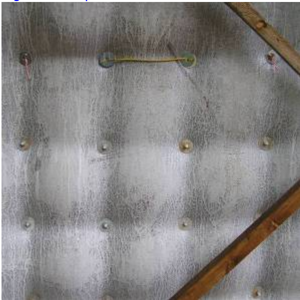
Completed Concrete Pour
