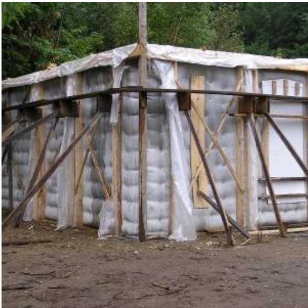
Completed Concrete Pour
