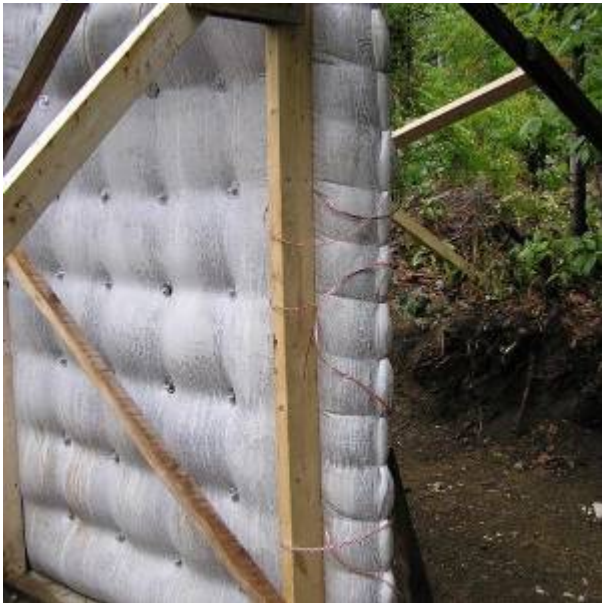
Completed Concrete Pour
