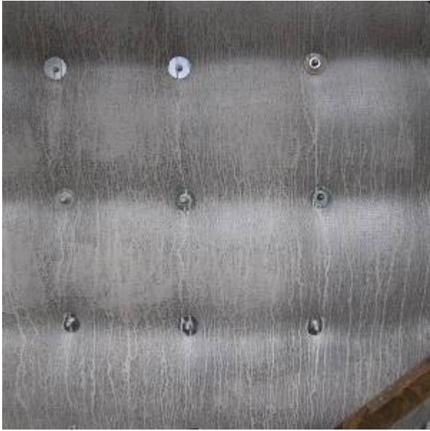
Completed Concrete Pour
