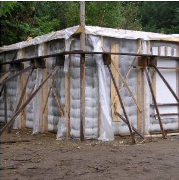
Completed Concrete Pour
