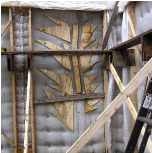
Completed Concrete Pour
