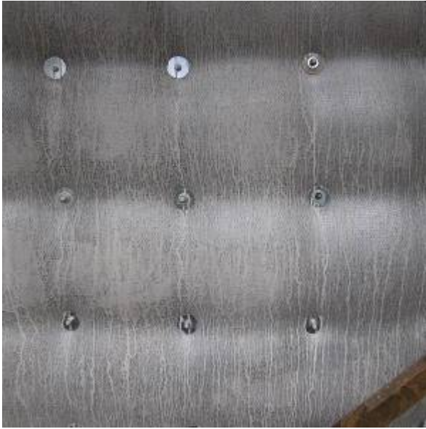
Completed Concrete Pour
