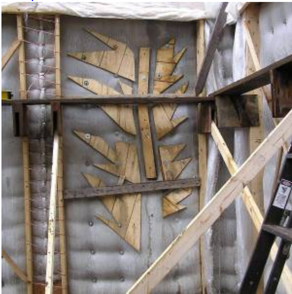
Completed Concrete Pour
