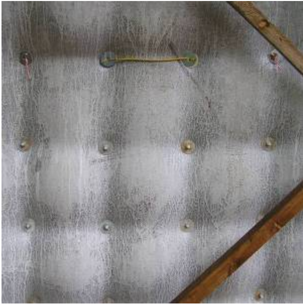
Completed Concrete Pour
