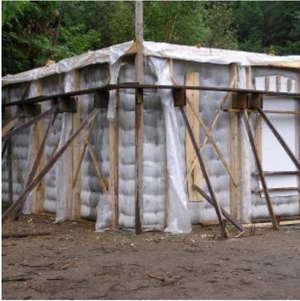
Fig. 15. Completed Concrete Pour
